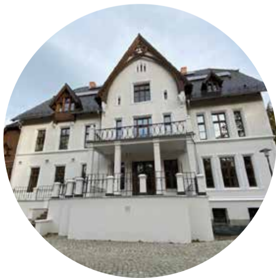
Urząd Miejski w Głuszycy instalacja fotowoltaiczna
