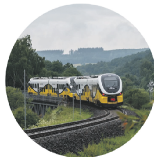
Linia kolejowa 266 transport publiczny
