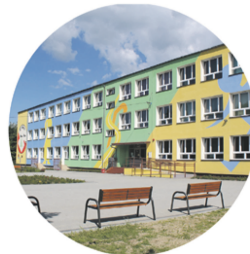
Czyste Powietrze termomodernizacja budynku
